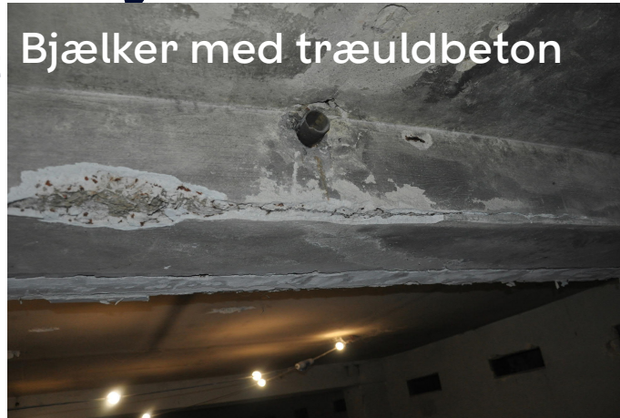
Træuldbeton delvis fjernet
