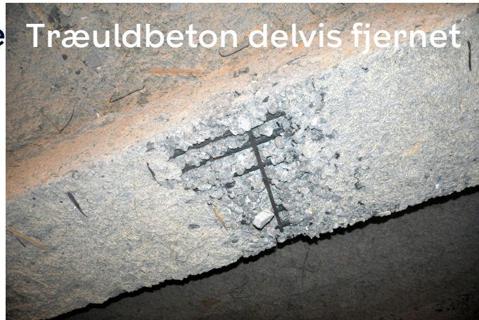
Træuldbeton delvis fjernet
