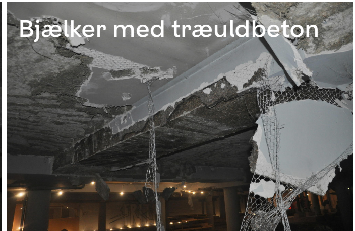
Træuldbeton delvis fjernet
