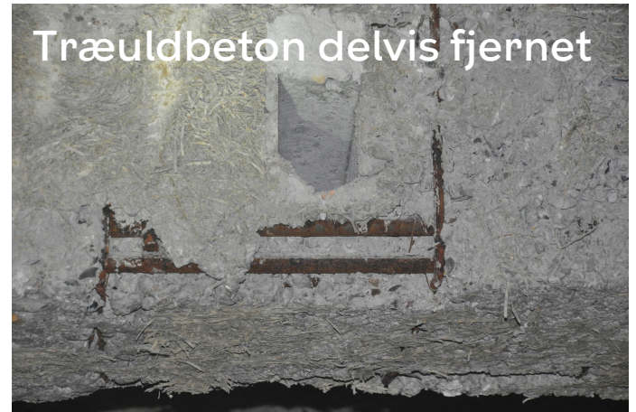
Træuldbeton delvis fjernet
