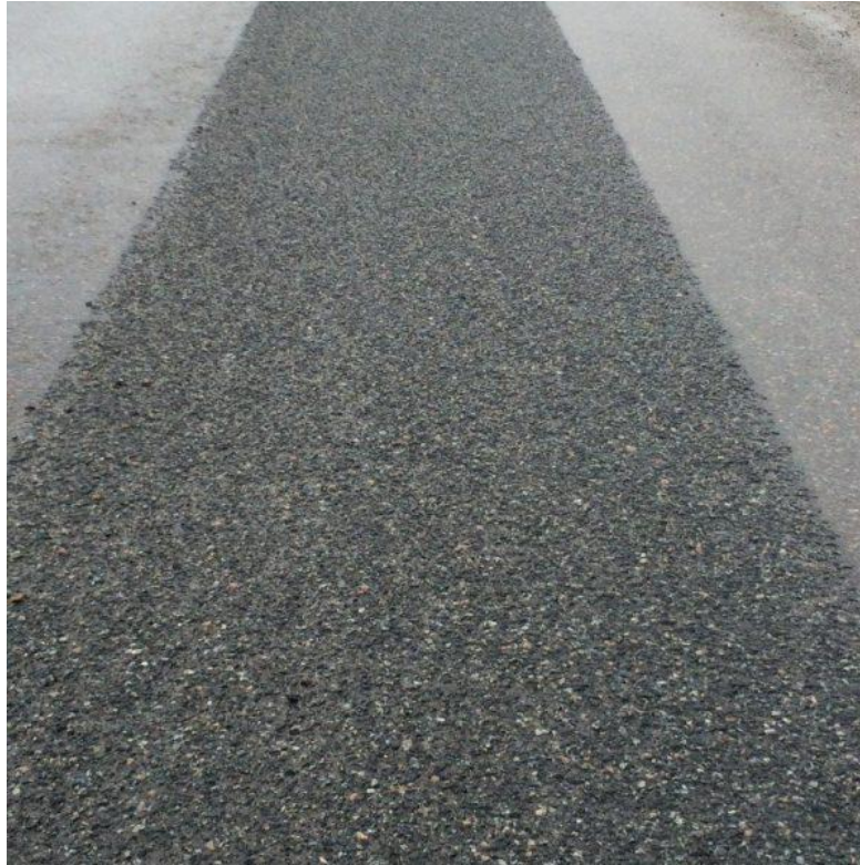
Partiel OB udført med emulsion og 5/8 eller 2/5 mm granitskærver.
