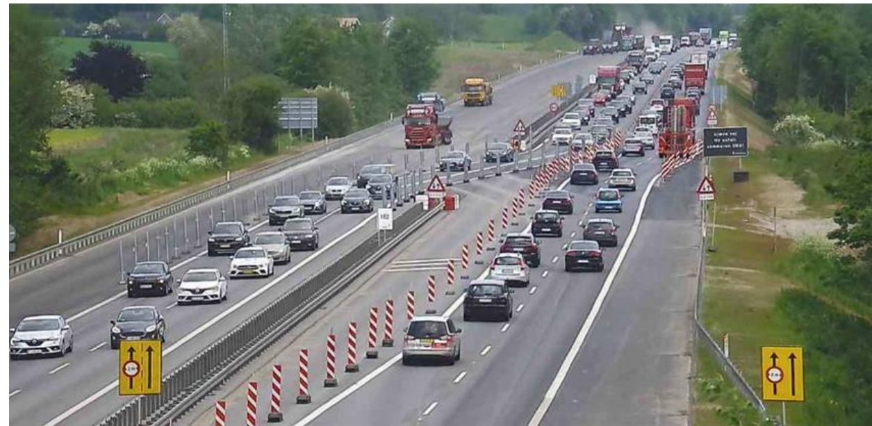
Tilbageledning af trafik fra 4+0 til 2+2 (Fynske Motorvej)
