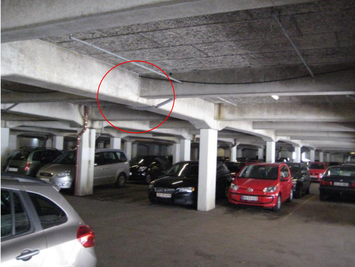
Preislers Plads, markering af krydsningspunkt og træbeton på underside af dæk
