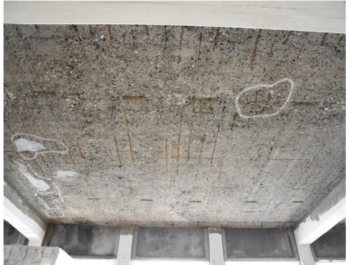
Et andet dæk, hvor træbetonen er fjernet
